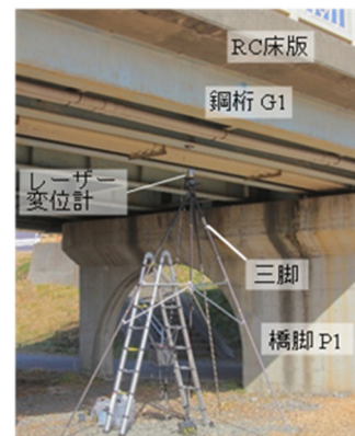
図 3. P1-P2 径間の鉛直方向変位の計測
