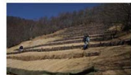
やがて土に還るヤシネットで土砂を止め、周囲からの種の実生を待ったり、植樹をする。
