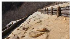
周辺のカラマツの間伐材で、まず階段状の土留め工をほどこし、
