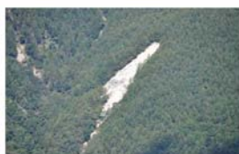
山腹の大規模崩壊地
